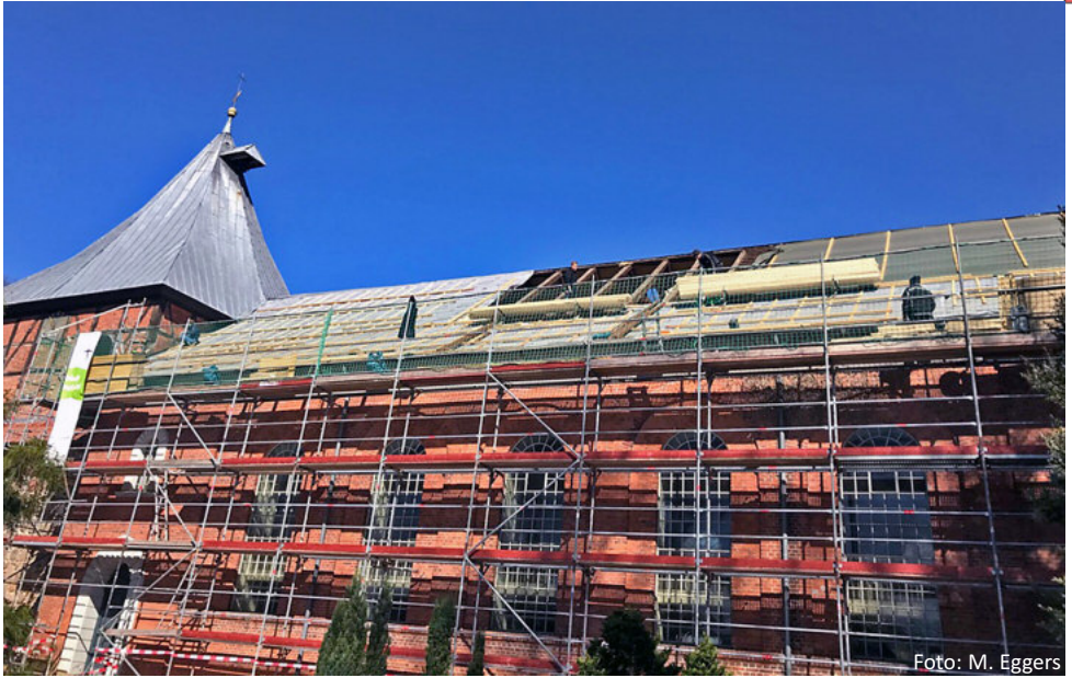
Baustelle Lütauer Kirche
