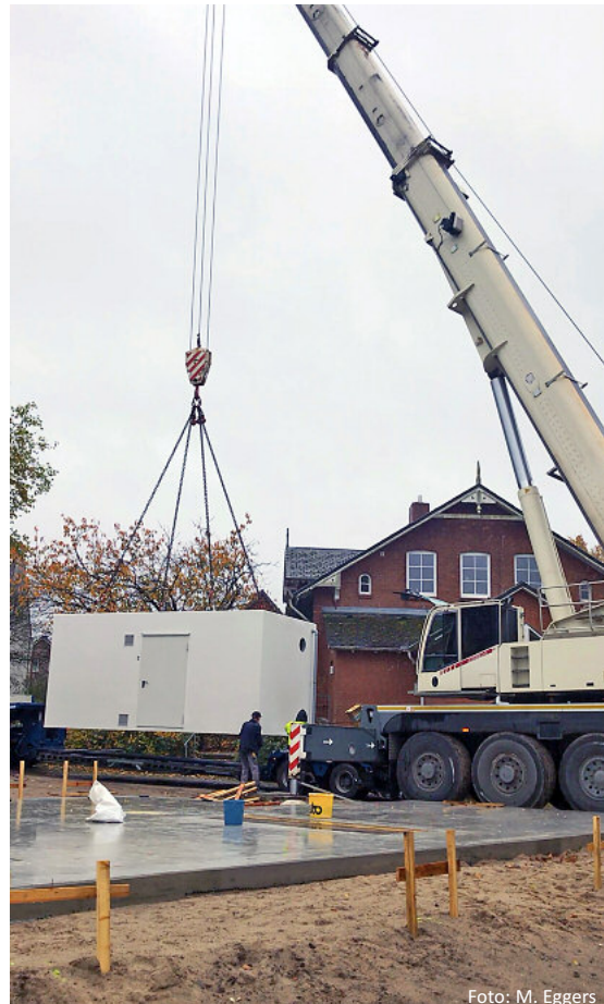
Das neue Heizhaus wird gesetzt
